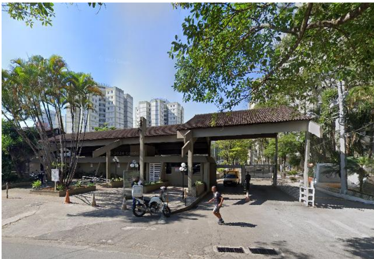
Foto 1 – Entrada do Condomínio
