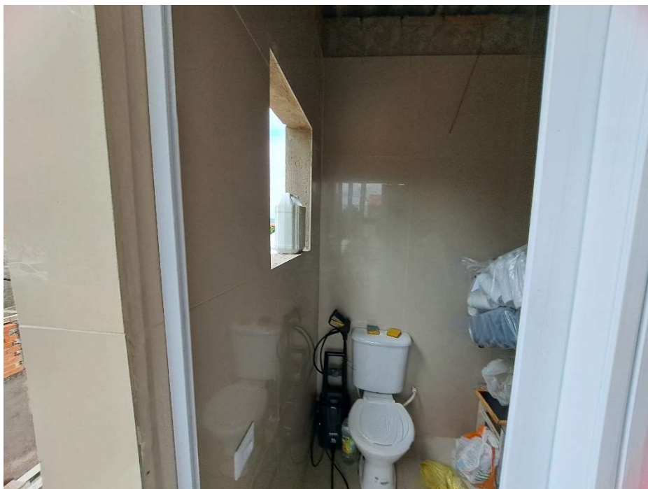
VISTA DO BANHEIRO DA ÁREA DE SERVIÇO DA CASA 1
