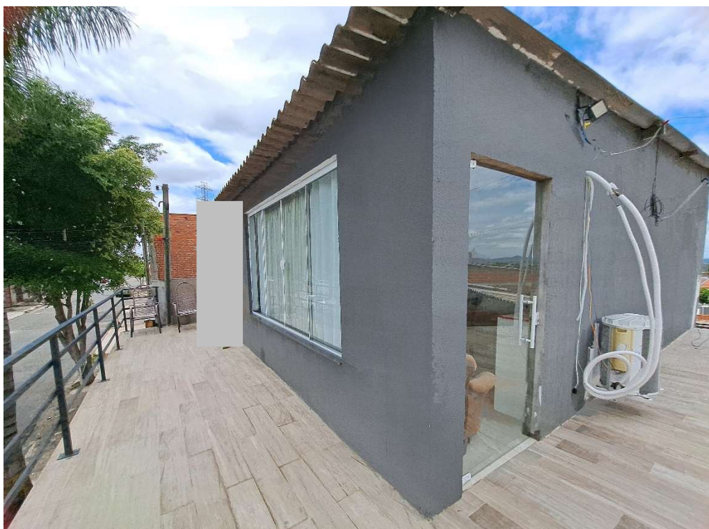
VISTA DO TERRAÇO DA CASA 1
