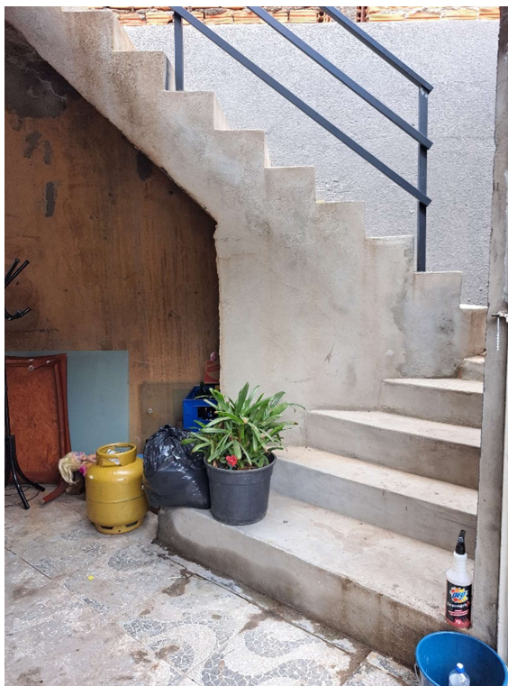
VISTA DA ESCADA DE ACESSO DA CASA 1
