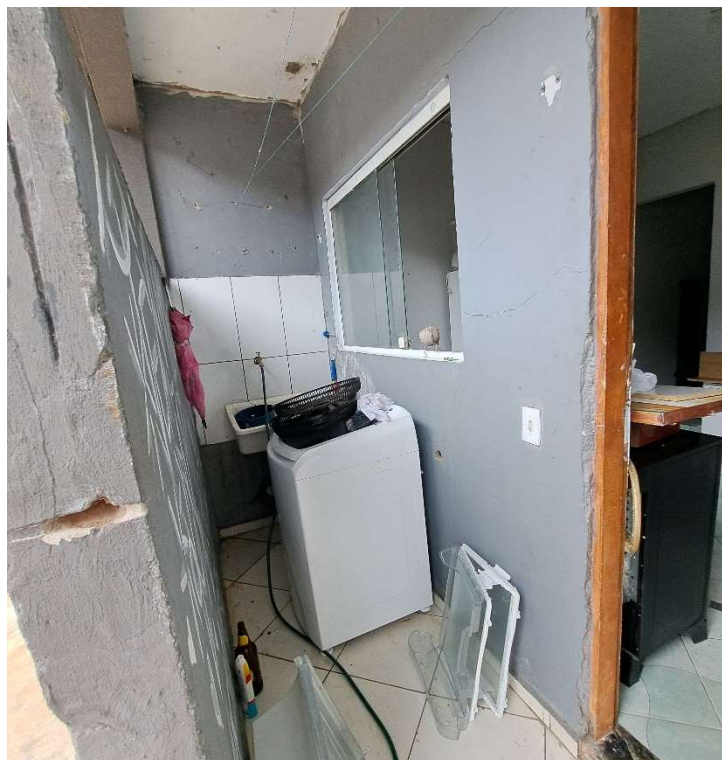
VISTA DA LAVANDERIA DA CASA 4
