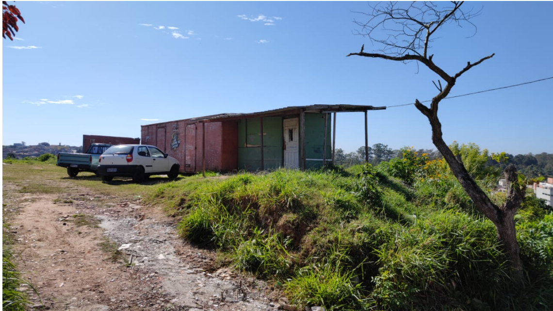
Instalações improvisadas na Gleba A
