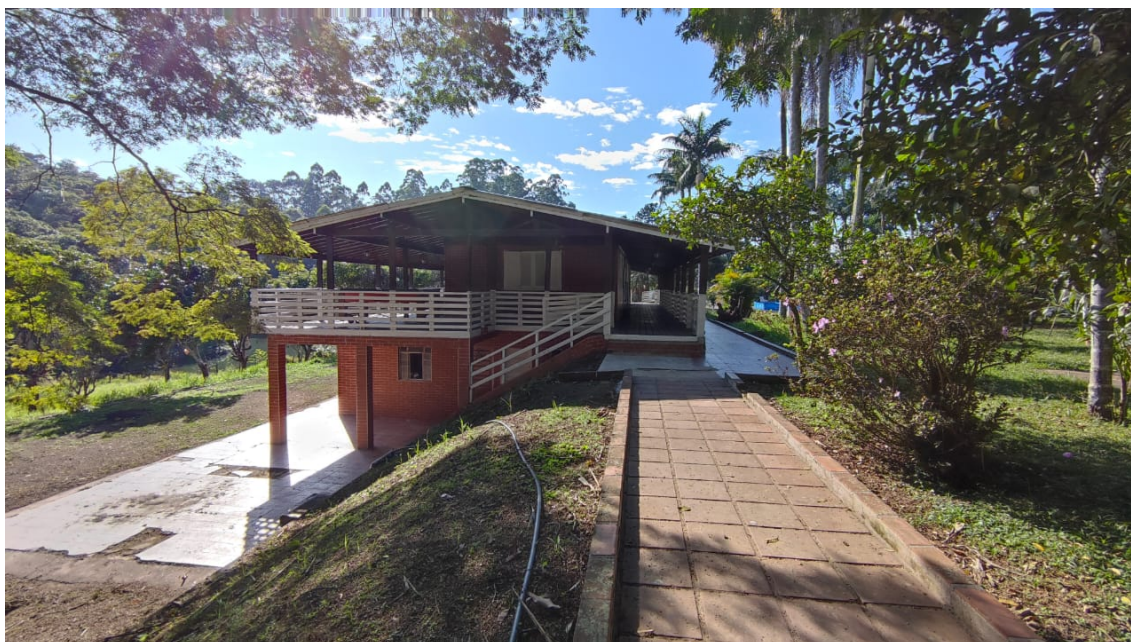
Acesso da casa 2
