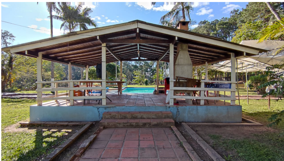
Área da piscina casa 2
