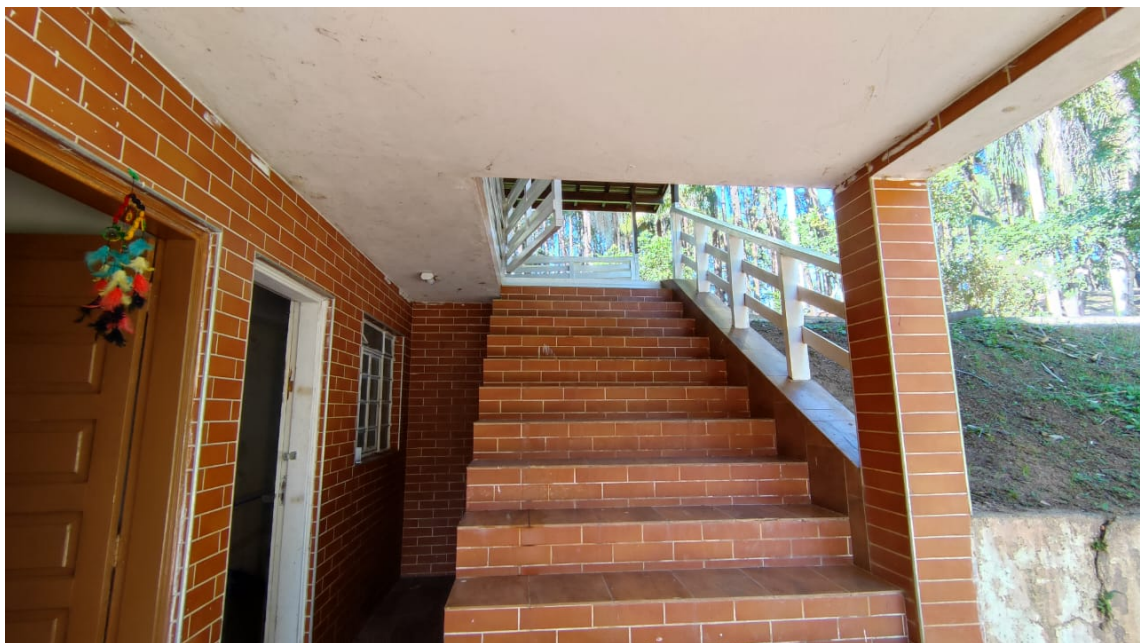
Acesso ao subsolo casa 2
