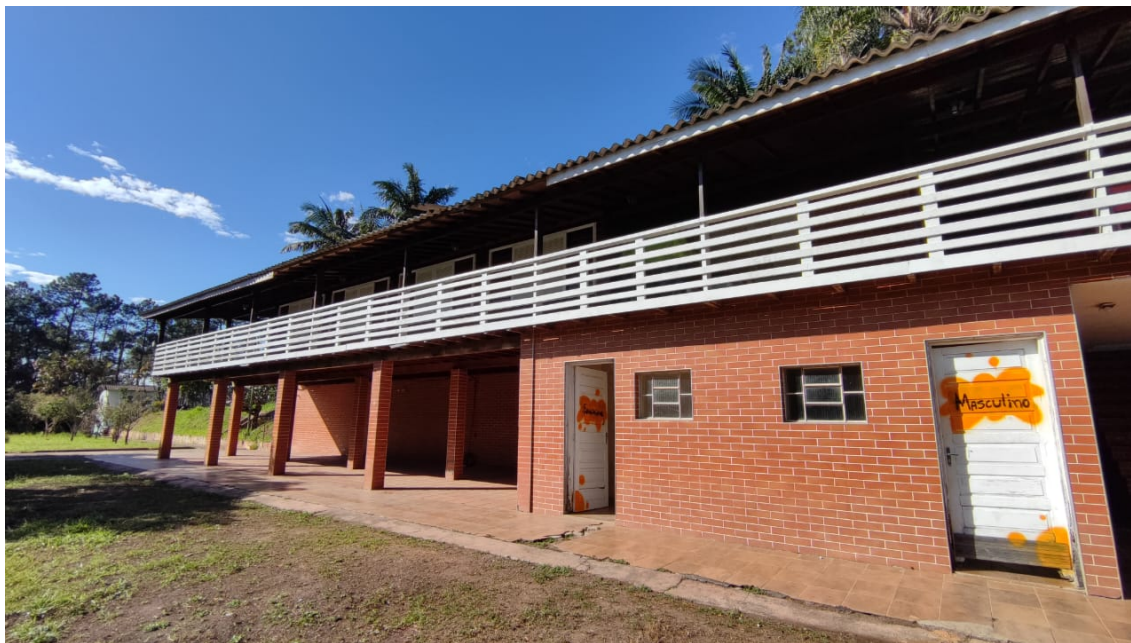
Vista lateral da casa 2 com subsolo
