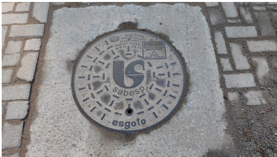
Esgoto canalizado na Rua Américo Turini
