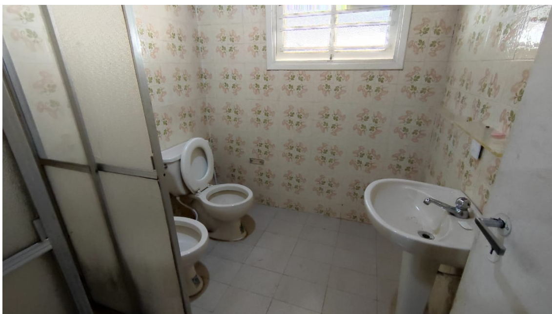
Banheiro do subsolo casa 2
